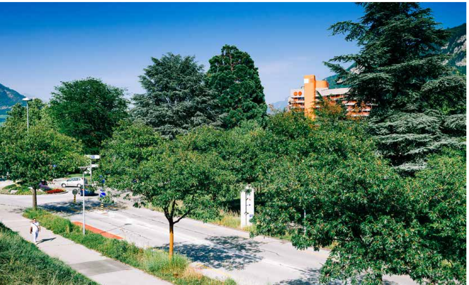
Quarante ans après son ouverture, l'Hôpital se fond dans la végétation et le paysage.
