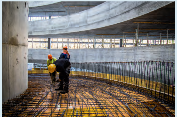
Ouvriers sur le chantier en février 2019.
